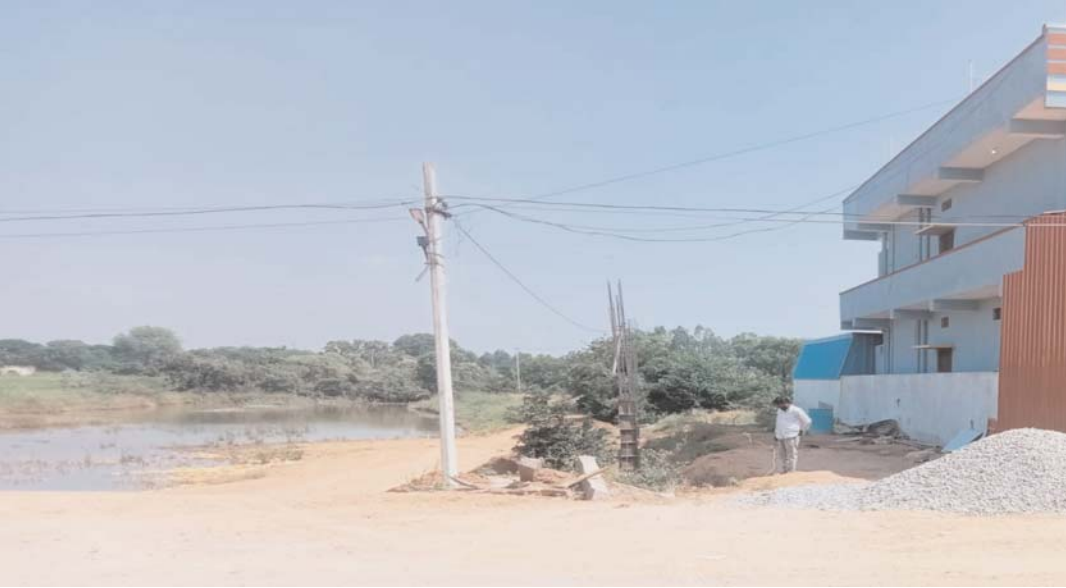
ఇప్పటికైనా ఇరిగేషన్ శాఖ అధికారులు, స్థానిక తహశీల్దార్ నిర్ణయించి, జరుగుతున్న అక్రమ నిర్మాణాలను తక్షణమే పంచాయతీ కార్యదర్శి తక్షణమే స్పందించి జాయింట్ సర్వే కూల్చివేసి చెరువు భూములను కాపాడాలని ఉన్నతాధికారులను గ్రామ ప్రజలు కోరుతున్నారు.
